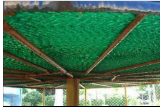
รูปแสดงหอผึ่งน้ำ (Cooling tower) ก่อนและหลังเปลี่ยนแผ่นฟิลเตอร์
