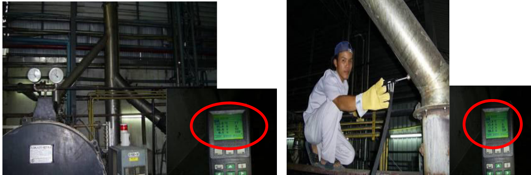
รูปแสดงลักษณะการตรวจวัดประสิทธิภาพหม้อไอน้ำก่อน-หลังปรับปรุง
