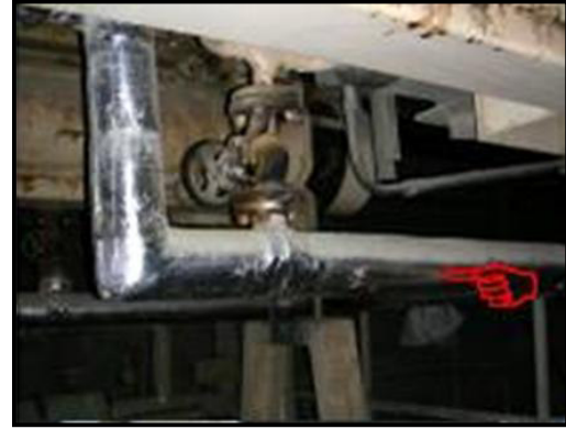
รูปแสดงก่อน-หลังหุ้มฉนวนท่อส่งไอน้ำ
