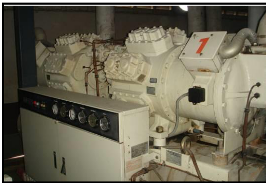
รูปแสดงเครื่องทำน้ำเย็นที่ใช้งานของอาคารก่อนและหลังการปรับปรุง
