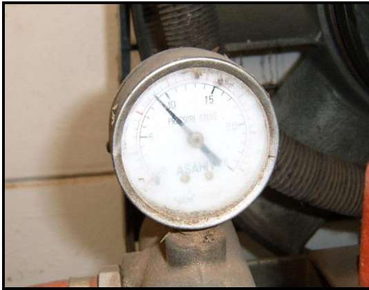
รูปแสดงการปรับลดแรงดันเครื่องอัดอากาศ ก่อนปรับปรุงและหลังปรับปรุง
