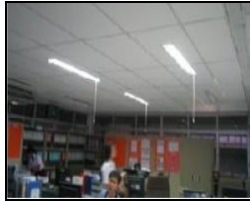
รูปแสดงบริเวณห้องทำงานที่มีการติดตั้งสวิตช์กระตุกก่อนและหลังการปรับปรุง
