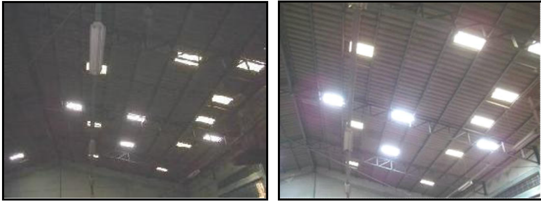
รูปแสดงการปรับปรุงแผ่นใสของช่องรับแสงสว่างธรรมชาติบนหลังคา ก่อนและหลังการปรับปรุง
