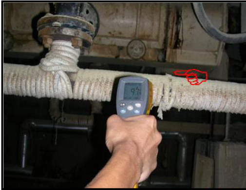
รูปแสดงก่อน-หลังหุ้มฉนวนท่อส่งไอน้ำ
