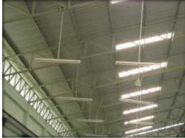
รูปแสดงดวงโคมฟลูออเรสเซนต์แบบธรรมดาที่ใช้ในบริษัท
