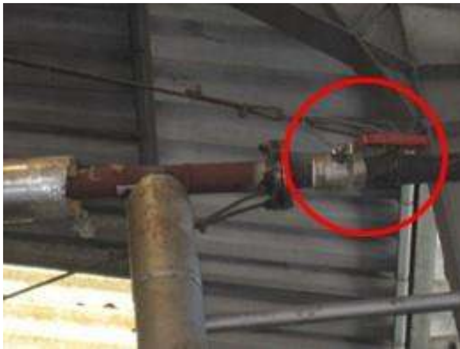
รูปแสดงการติดตั้งวาล์วควบคุมคอนเดนเสท (หลังการปรับปรุง)
