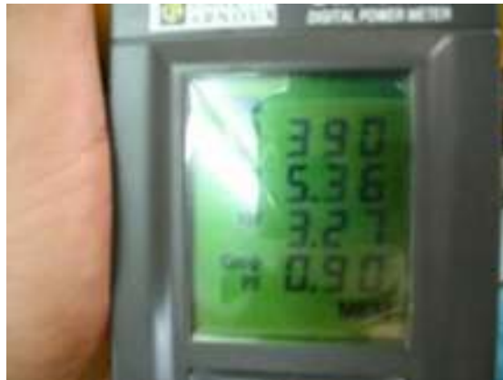
รูปสภาพหลังการปรับปรุง
