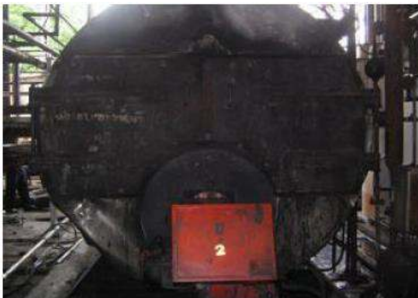
รูปก่อนการปรับปรุง
