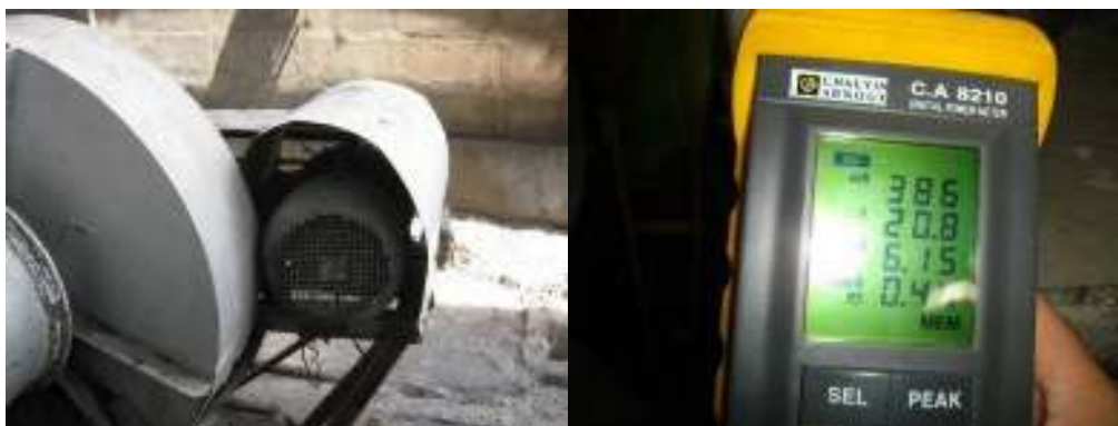
รูปภาพก่อนการปรับปรุง
