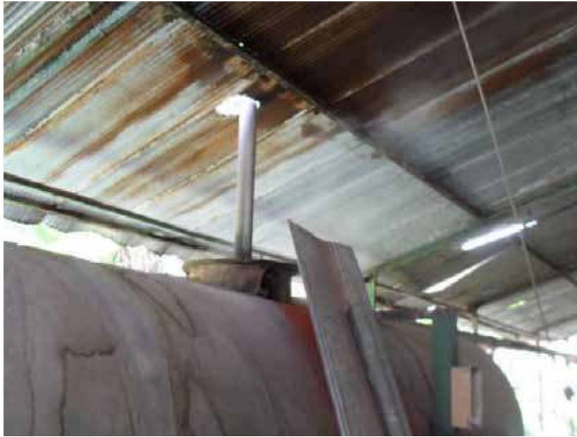
รูปแสดงการซ่อมแซมถังคอนกรีต (หลังปรับปรุง)
