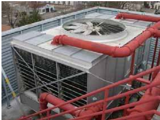
รูปที่ 1-72 Induced draft cooling tower
