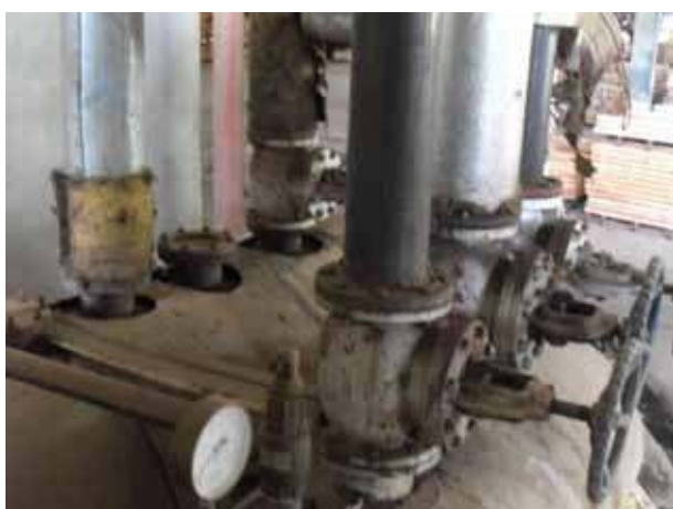
รูปแสดงระบบท่อไอน้ำและการตรวจวัด
