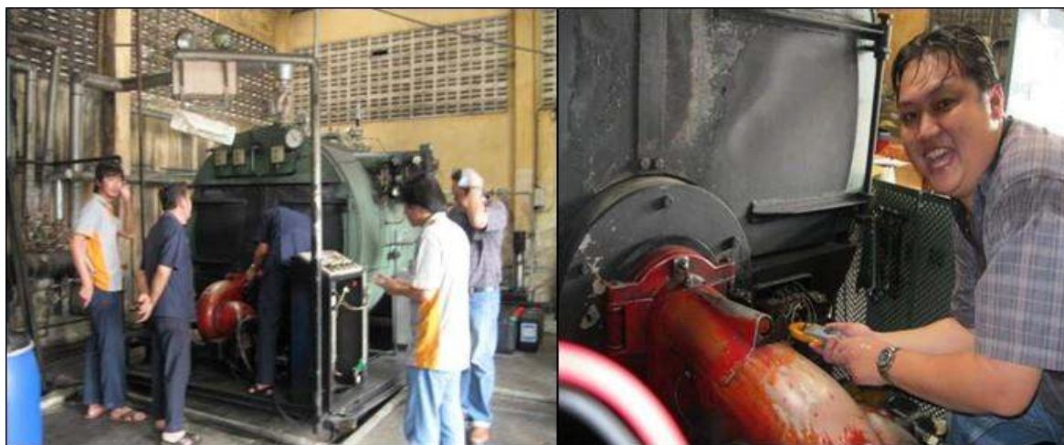
รูปการสำรวจและตรวจวัดการใช้พลังงานและความเหมาะสมการเดินท่อไอน้ำสู่ถังน้ำมันเตา
