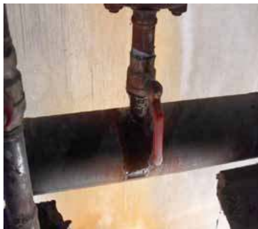
รูปแสดงการรั่วไหลของไอน้ำจากชุดกับดักไอน้ำ
