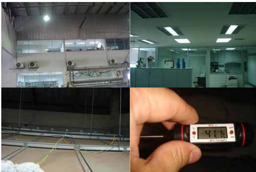
รูปแสดงการสำรวจกรอบอาคารห้องผู้บริหาร 1, 2 และ 3 บริเวณชั้นลอยของโรงงาน
