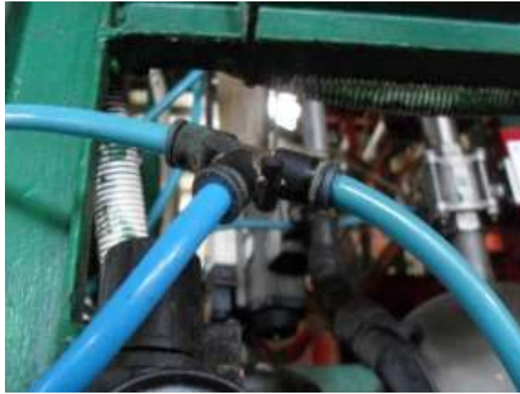
รูปแสดงการปรับปรุงจุดรั่วไหลของระบบอากาศอัดในโรงงาน
