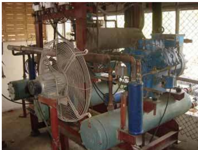
รูปแสดงคอนเดนเซอร์ของชุดทำความเย็น
