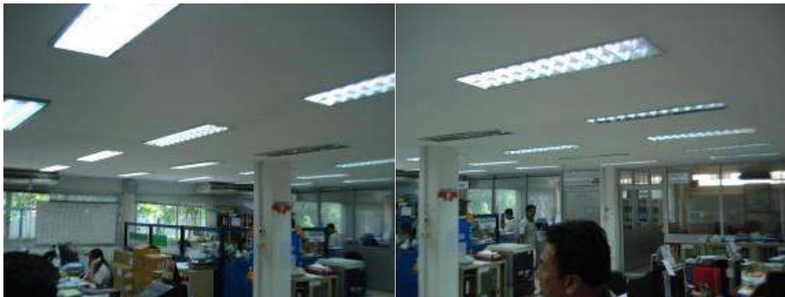
รูปหลอดฟลูออเรสเซนต์ไฟฟ้าแสงสว่าง ก่อนปรับปรุง
