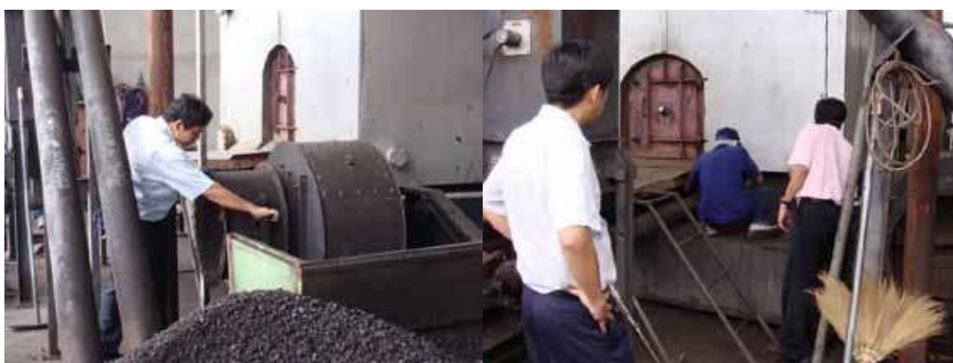
ภาพแสดงการปรับปรุงโดยการปรับตั้งปริมาณอากาศให้เหมาะสม
