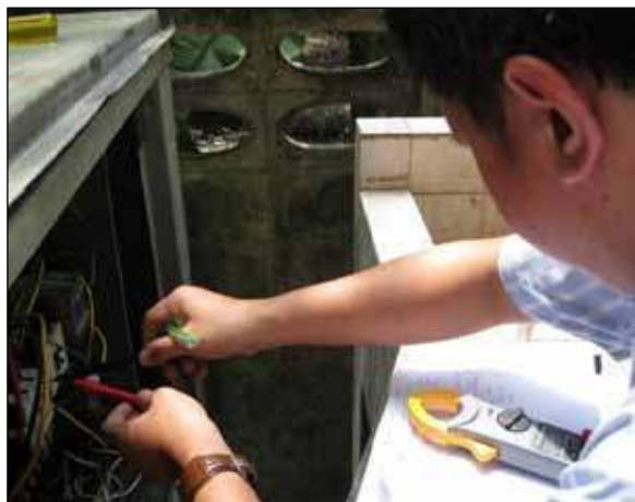
รูปแสดงการตรวจวัดกำลังไฟฟ้าและอุณหภูมิของระบบทำความเย็น
