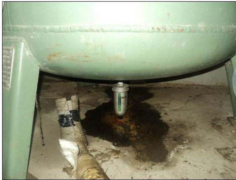
รูประบบระบายน้ำของอากาศอัดแบบ Auto Drain หลังปรับปรุง
