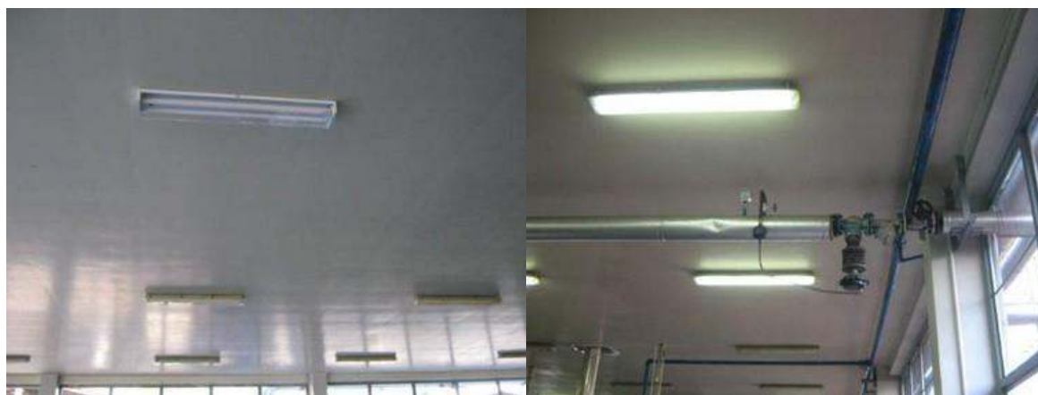
รูปสภาพหลังการปรับปรุง
