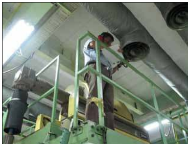
รูปแสดงการตรวจวัดกำลังไฟฟ้าและอุณหภูมิของระบบทำความเย็น
