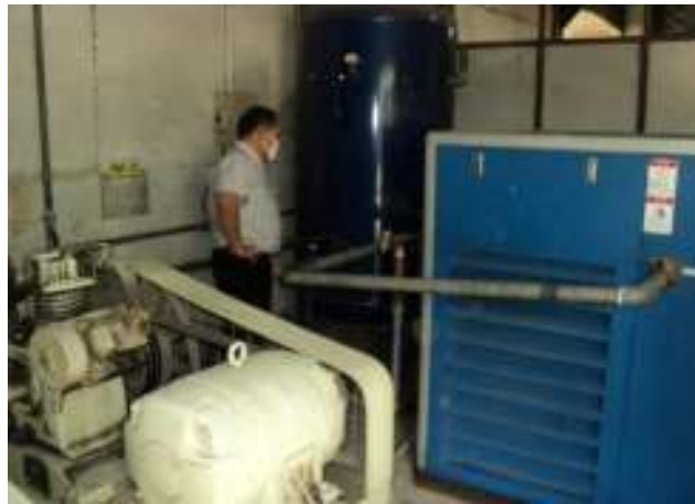
รูปเครื่องอัดอากาศที่ใช้ในกระบวนการผลิตขนาด 37 กิโลวัตต์
