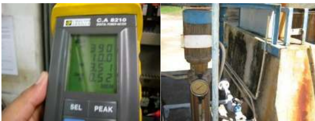
รูปสภาพก่อนการปรับปรุง
